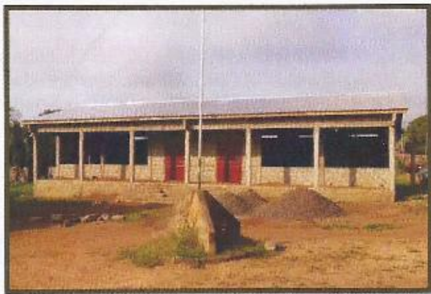
Grundschule Gbaffo-Dogoudo ein 2-klassiges Schulgebäude
