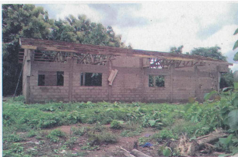
Rohbau des 2-klassigen Schulgebäudes in Aglamidjodji im Nov. 22
