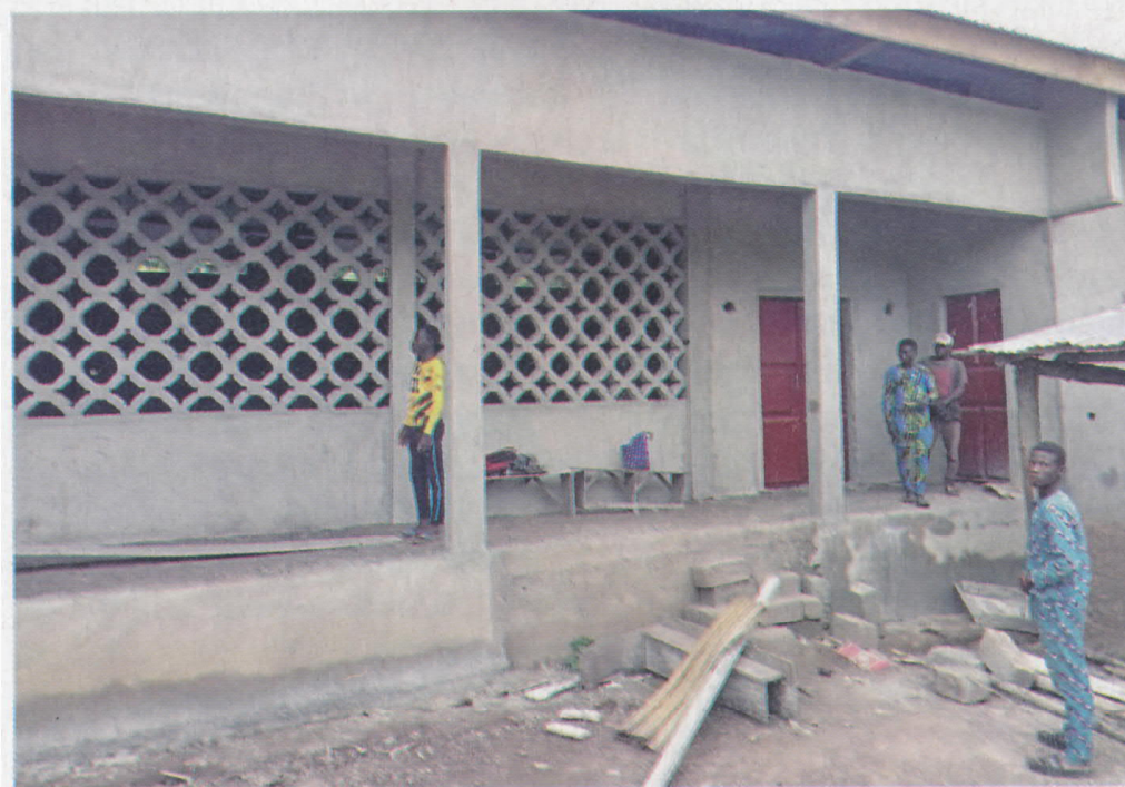
3-klassiges Schulgebäude in Agblakindji im August 2022
